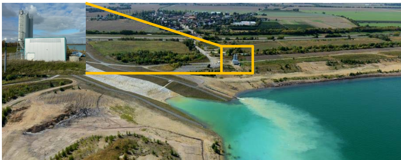
Abb. 15: Stationäre Neutralisationsanlage am Zwenkauer See und Ausbreitung der Kalkfahne im See mit dem Flutungswasser (Quelle: LMBV)
