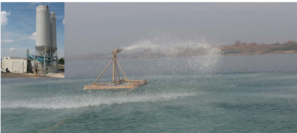
Abb. 6: Stationäre Neutralisationsanlage am Hainer See (links oben) und Neutralisationsmittelverteilung über der Wasseroberfläche (Quelle: UIT/LMBV)
