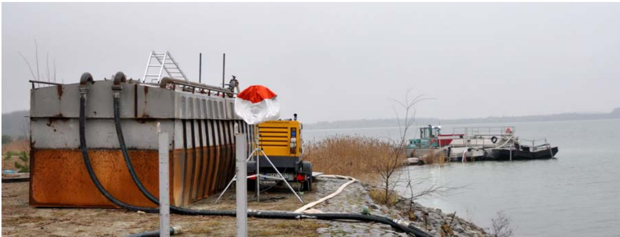
Abb. 9: Anmischcontainer und Gewässerbehandlungsschiff „Puma“ mit Unterwassereintrag nach dem Freistahlprinzip (Quelle: BGD)
