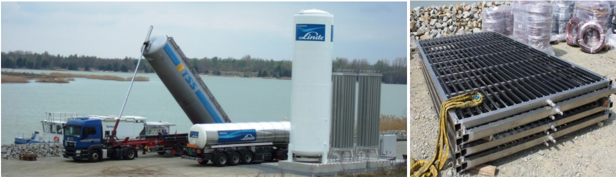
Abb. 17: Tank während der Befüllung mit verflüssigtem CO 2 sowie zugehörige Verdampferanlage, Anlegestelle mit Gewässerbehandlungsschiff hinter dem LKW während der Beladung mit Kalkhydrat (links) und Begasungsrahmen mit Mikroporen vor der Installation am Seegrund (rechts) (Quelle: LMBV)
